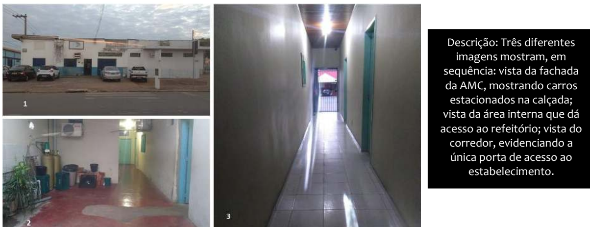
Figura 1. Vista da AMC em diferentes ângulos (1 = fachada externa; 2 = área interna, que dá acesso ao refeitório; 3 = corredor e a única porta de acesso).
