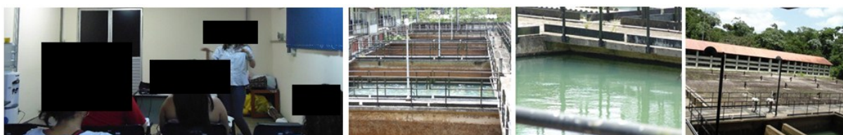
Figuras 1, 2, 3 e 4: Auditório da COSANPA e os tanques de tratamento da água. Foto: José Bittencourt da Silva, 2014.
