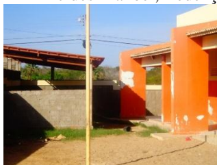
Foto 7 – Pátio - EM Alcides Manoel, Redenção, Mossoró/RN
