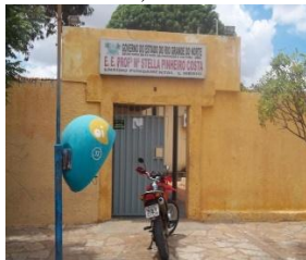
Foto 1- Fachada EE Maria Stella Pinheiro, Planalto 13 de maio, Mossoró/RN
