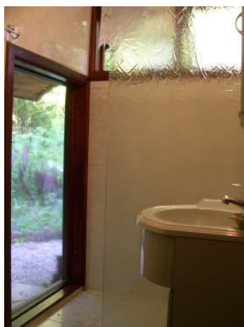
Painel de vidro fixo instalado no box do banheiro, substituindo a parede de vedação externa. Fonte: acervo do entrevistado Col
