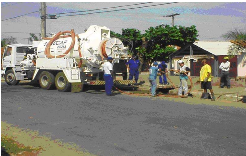
FIGURA 05 - GENARO (2004) - Veículo jato/vácuo de alta pressão para desobstrução de redes e ramais, Cuiabá-MT.
