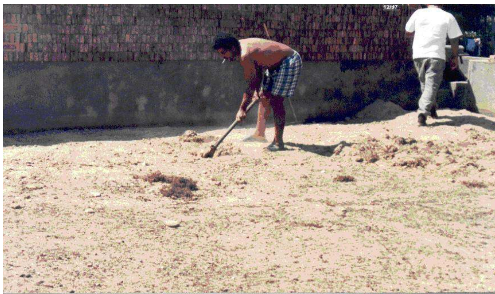
FIGURA 06 - GENARO (2004) - Retirada de areia do leito de secagem de lodo, ETE Parque Universitário – Cuiabá-MT.
