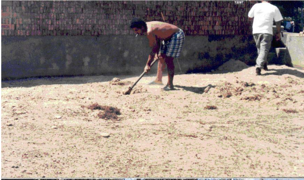
FIGURA 06 - GENARO (2004) - Retirada de areia do leito de secagem de lodo, ETE Parque Universitário – Cuiabá-MT.
