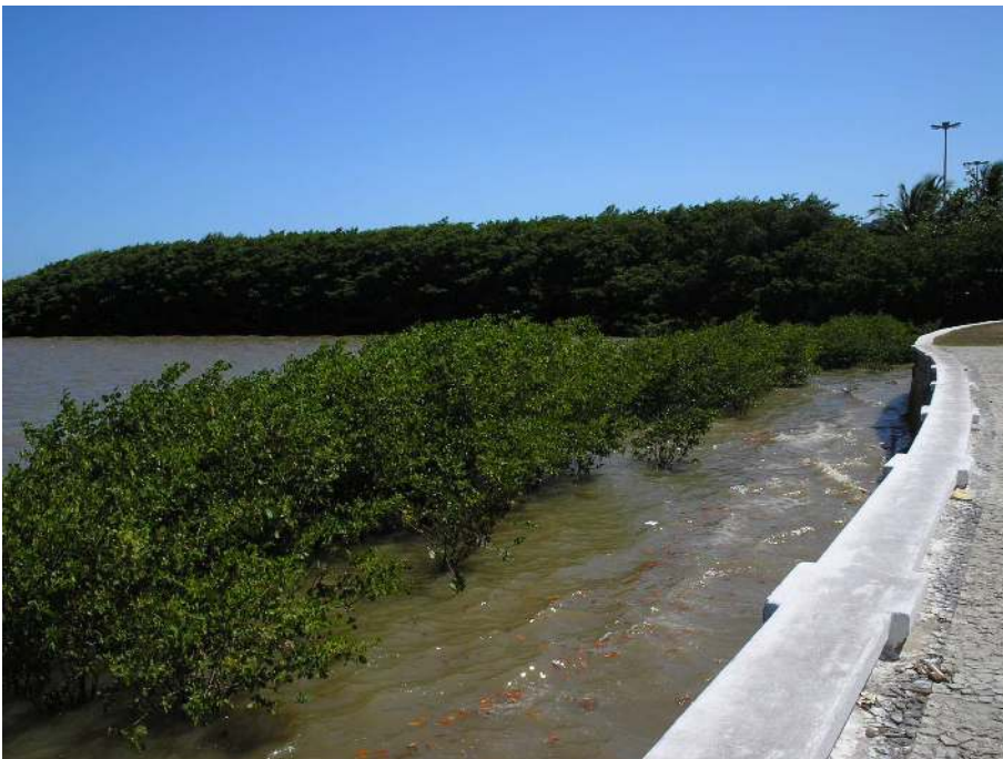
Figura 1. Manguezal da 13 de Julho.
