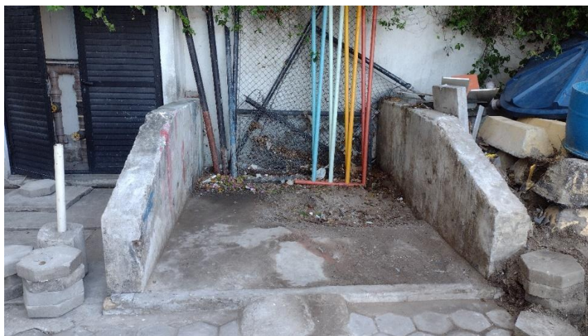
Figura VII: Baia que servia como depósito de resíduos da manutenção.
