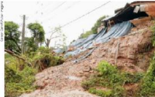
► Rua interrompida por deslizamento de encosta, causado pelas chuvas, em Santa Maria, estado do Rio Grande do Sul. Foto de 2015. A moradia na parte de cima foi danificada e estava sob risco de desabamento.
