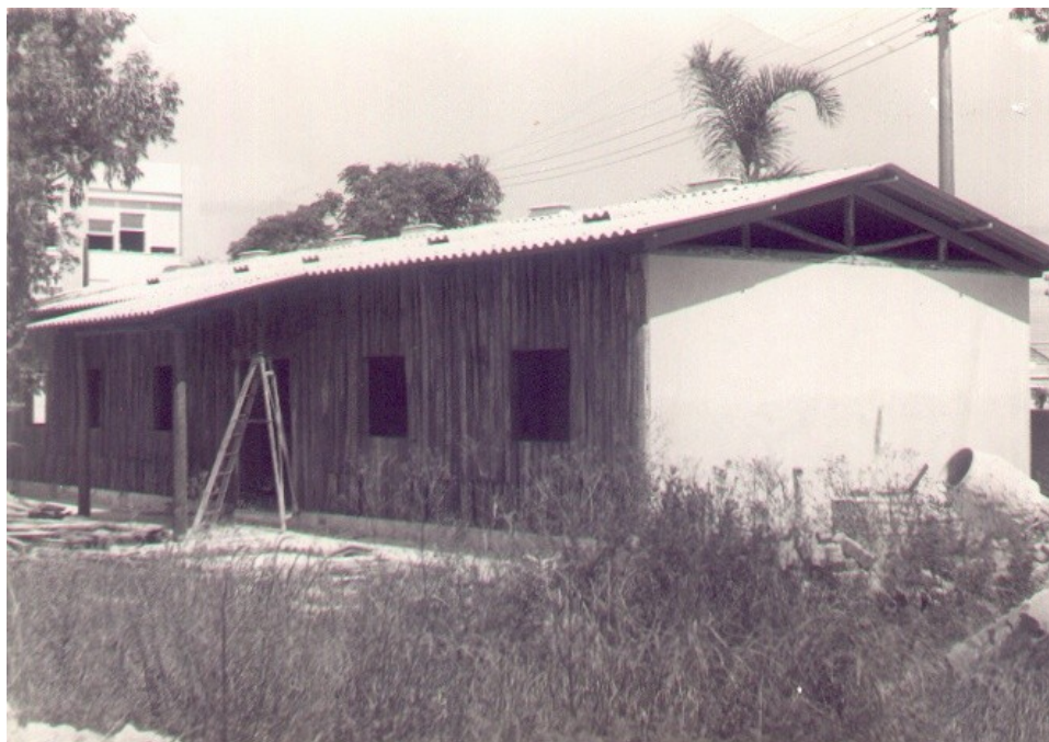
Figura 1: Construção da atual Sede do CTG (Instituto Federal Sul-Rio-Grandense, Pelotas, novembro de 1986). Fonte: Memorial da Escola
