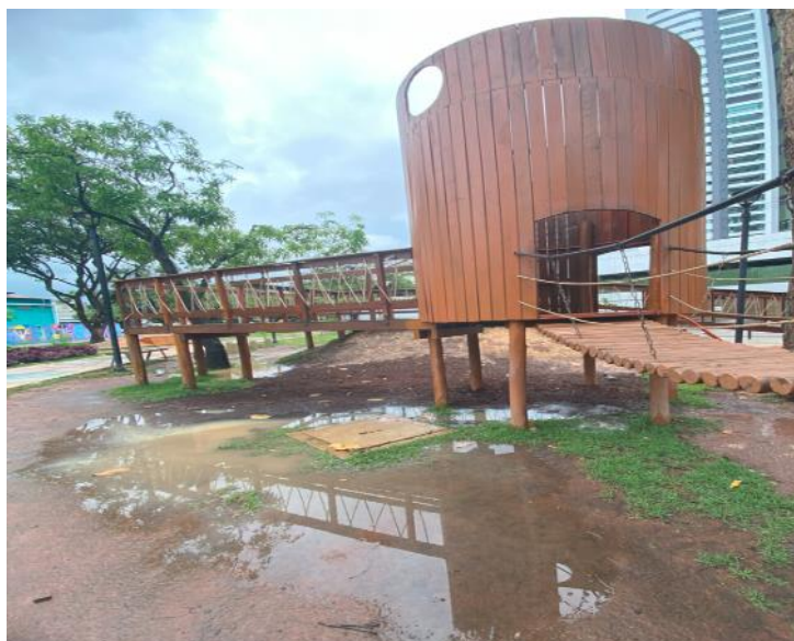
Figura 3 – Poça d’água formada em dia de chuva próxima da passarela da Casa Silo.
