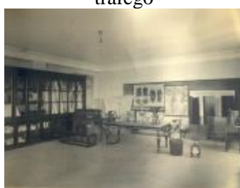
Figura 24: Sala de Pontes e tráfego
