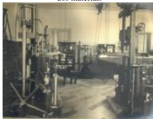
Figura 20: Politécnica. Gabinete de Resistência dos materiais
