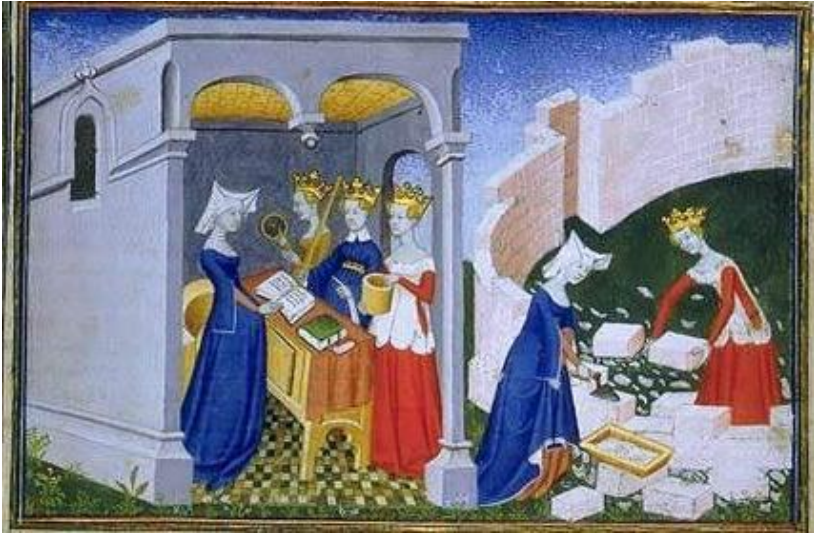
FIGURA 3 – Detalhe da construção da Cidade das Damas
