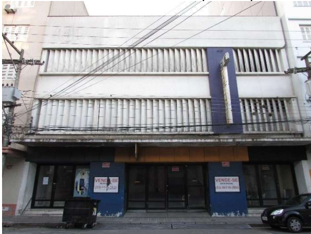
Figura 05 – Fachada atual da estrutura que comportou o Capitólio.
