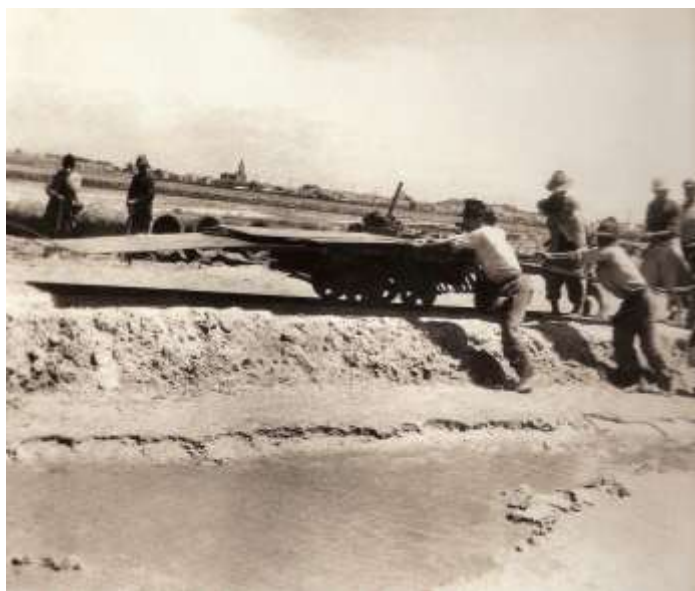
Figura 6: Foto da construção da refinaria Ipiranga 32 Fonte: Acervo da Ipiranga
