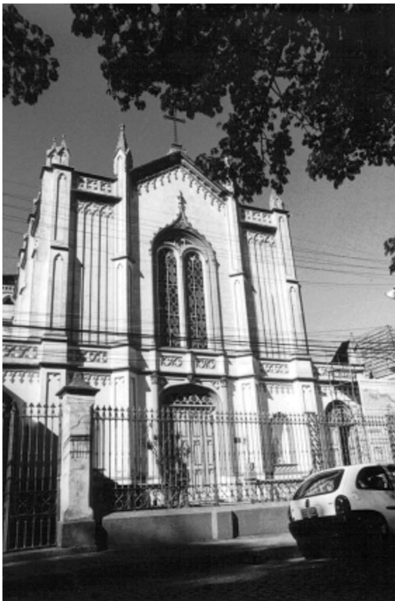
FIGURA 3 – Foto da fachada do prédio.
