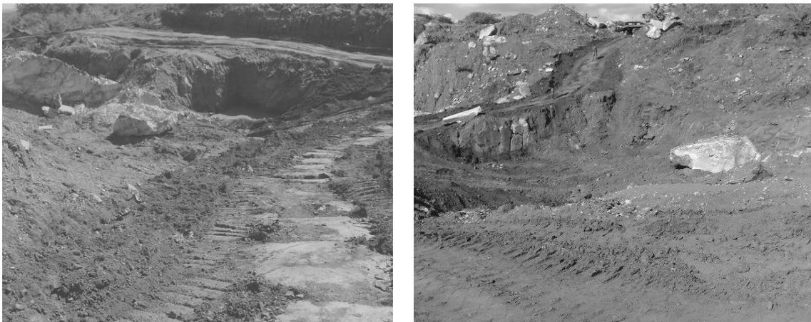
Figura 5 – Descapamento ou desbravamento do local para extração.
