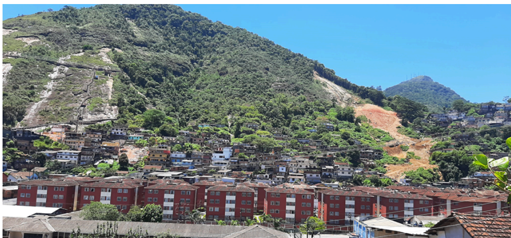
Figura 1. Foto que muestra uno de los deslizamientos ocurridos en 15 de febrero 2022 en el Morro de la Oficina.
